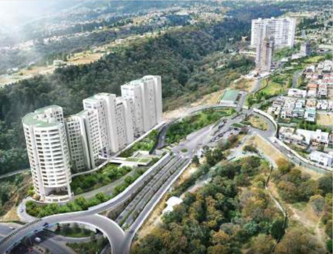
EDIFICIO BASALTO – CUMBRES DE SANTA FE
